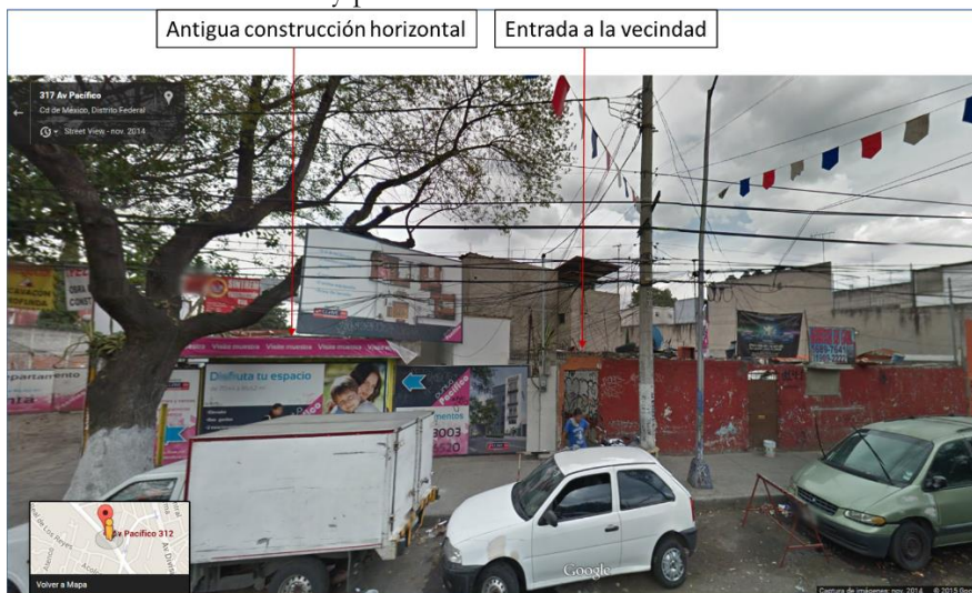
Imagen 4. Construcción de edificio y puerta de entrada a la vecindad
