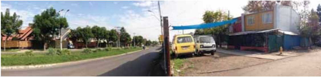
Figura 5: Condominios y viviendas sociales, separados por un muro, en Lo Hermida.
