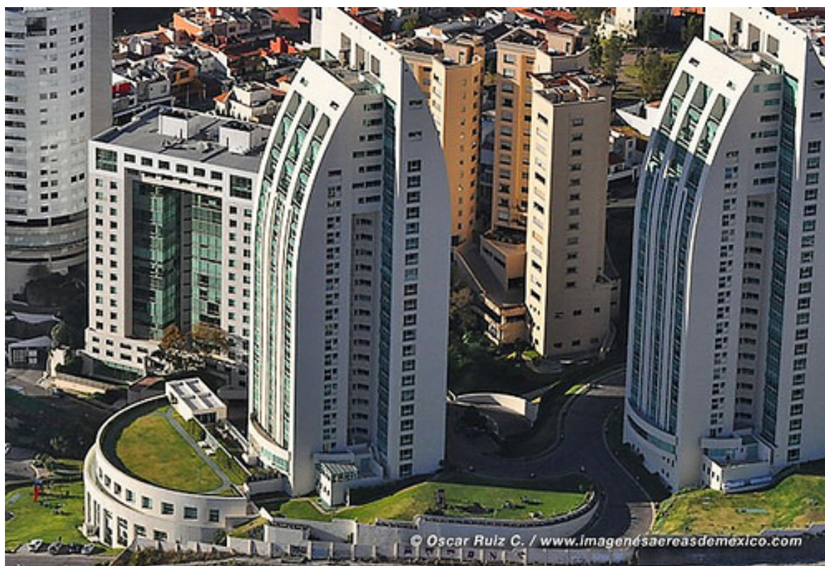
Fig. 3. Enorme desarrollo inmobiliario sobre subsuelo relleno de basura, Santa Fé, el desplazamiento además de construcciones y familias humildes sustituyo a un uso de suelo de basurero.
